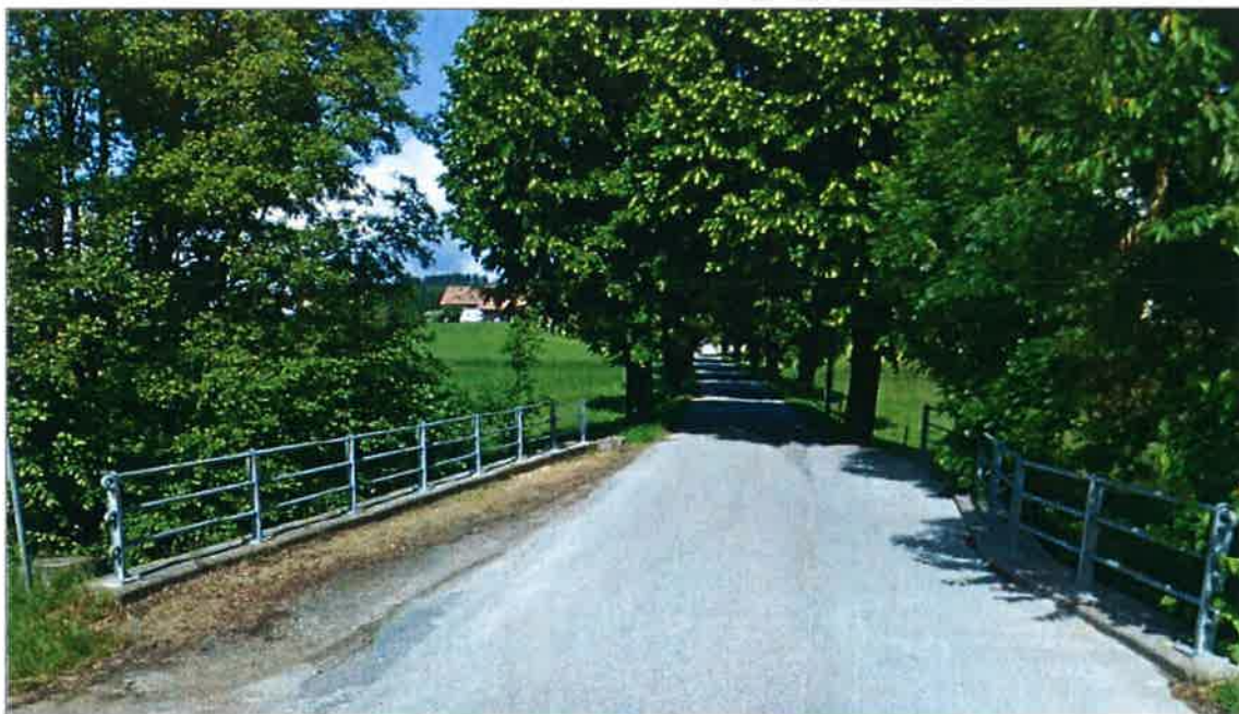
Figure 9 – Manque d'aménagement sur le chemin Sous-Gare
